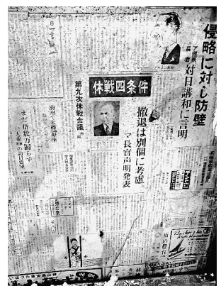
写真-2：札幌市「旧三菱鉱業寮」の壁下張り
