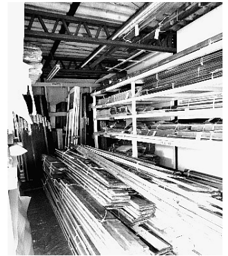
写真-6：再利用・解体材の保管（札幌市「旧三菱鉱業寮」現場）
