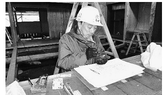
写真-5：再利用材の番付け作業（別海町「旧奥行臼駅通所」現場）
