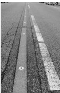
道路の散水口
