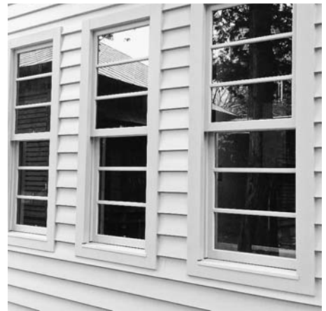
写真2 復元再生された上げ下げ窓
