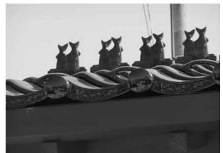
駅舎の屋根にもぶり
