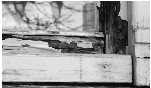
写真3 腐ってしまった窓枠
