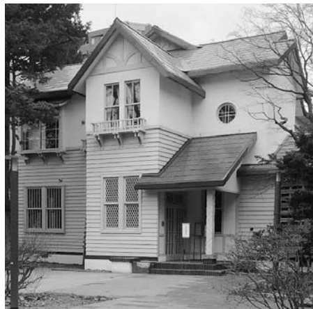
写真1 改修工事が終了した旧三菱鉱業寮
