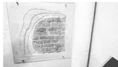
内装壁4層構造 レンガの上に4種類の漆喰
