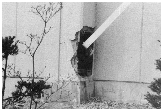
写真 3-5 筋違の破断
