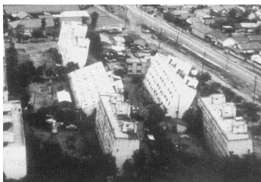
写真 4-13 全体沈下と全体傾斜
