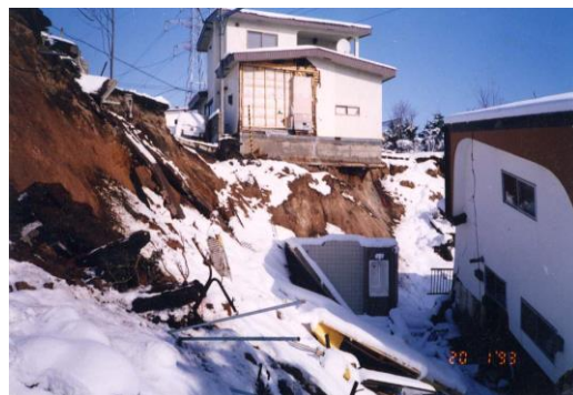
写真 2-4 斜面の崩壊(Cランク)
