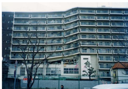
写真 4-14 構造躯体の損傷による部分的な傾斜
