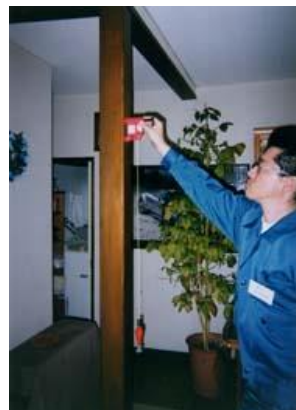
写真2-9 下げ振りによる傾斜の測定
