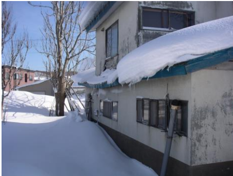
写真1 敷地内の積雪や屋根雪の状況
