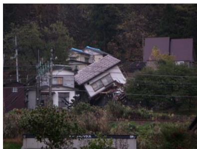
写真5-1 隣地に被害を及ぼした宅地
