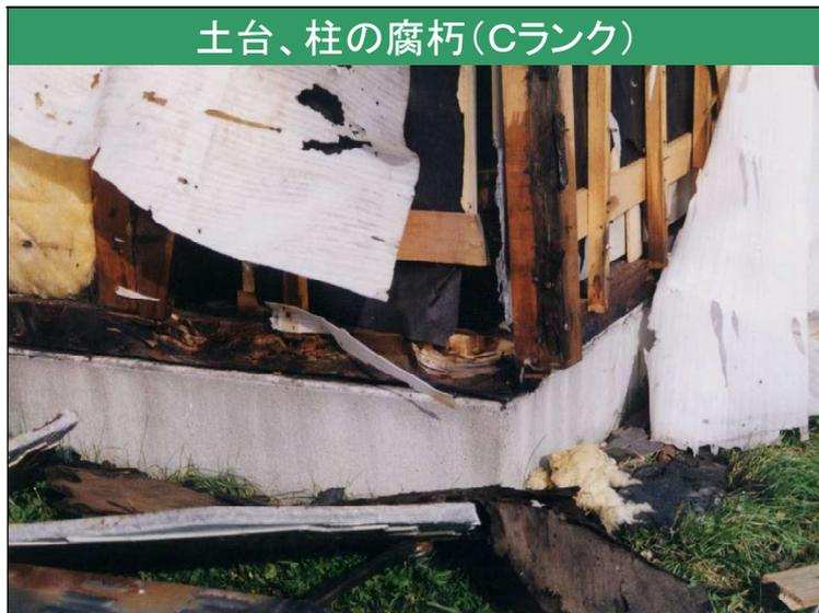
土台、柱の腐朽(Cランク)
