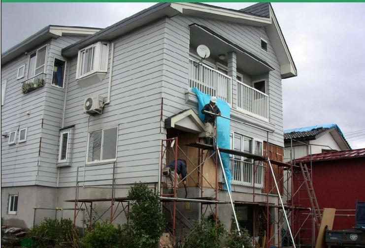
・この写真は、サイディングがずれたもので隙間ができた程度なのでBランクで判定します。
