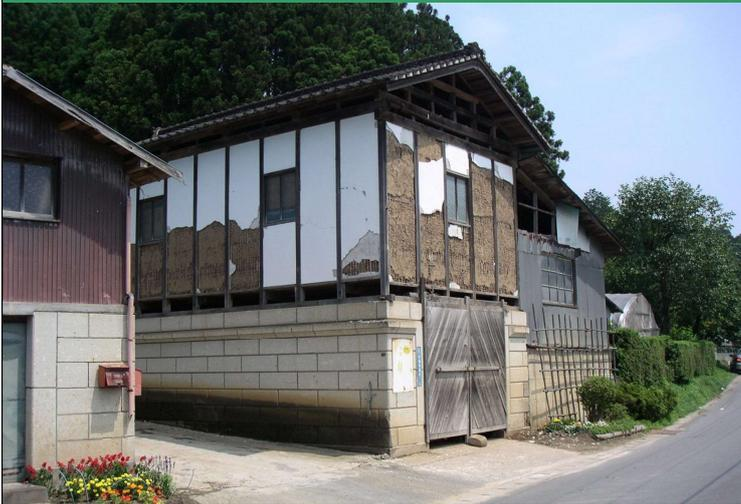
・この写真は、全面的に剥落しており、通行者などにも危険を及ぼす可能性があるため、危険度が高いと判断してCランクで判定します。
