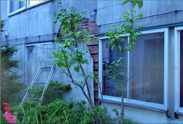
・この写真は、モルタル壁の剥落で、部分的なのでBランクで判定します。
