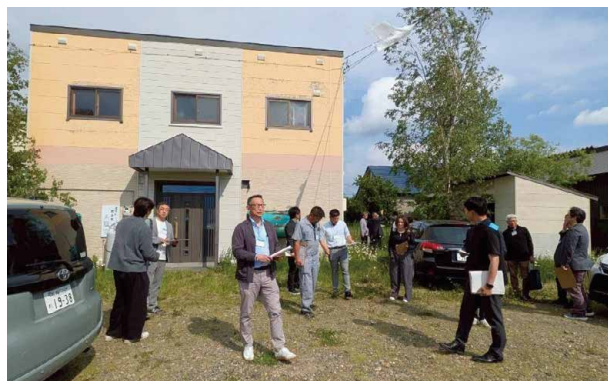
旧寄宿舎を現地で詳細に調査
