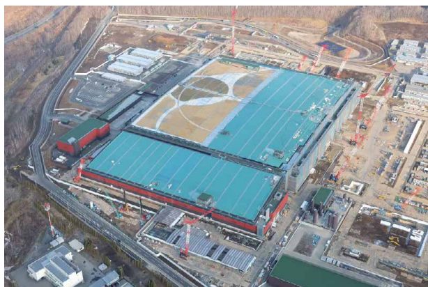
建設が進むラピダス千歳工場（IIM-1）
