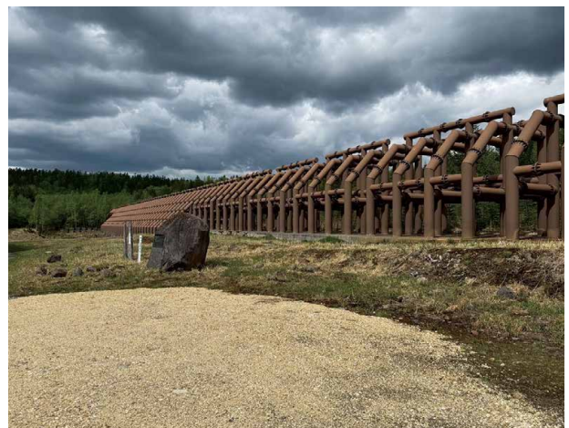
富良野川2号透過型ダム近景
