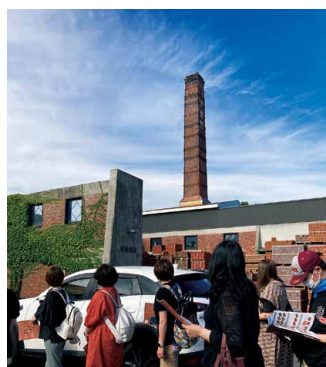
煙突が印象的な米沢レンガ工場
