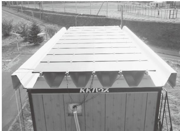
写真2 屋根面における太陽電池の設置状況
