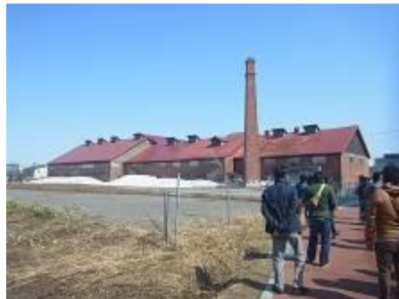
旧ヒダ工場 現地調査の様子
