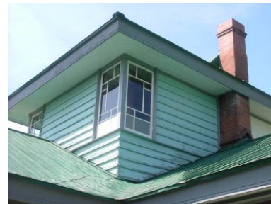
<破損した窓の部品から考察し、復元工事を行なった>
