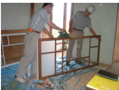
<破損した窓の部品から考察し、復元工事を行なった>
