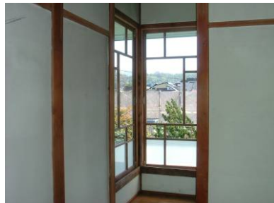
<破損した窓の部品から考察し、復元工事を行なった>
