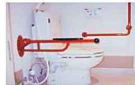
トイレ：しびん洗浄用の水栓金具設置
