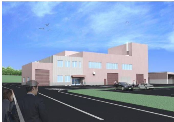
破碎・リサイクル施設
