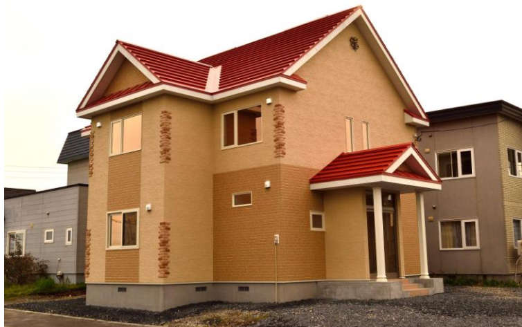
S邸新築工事
