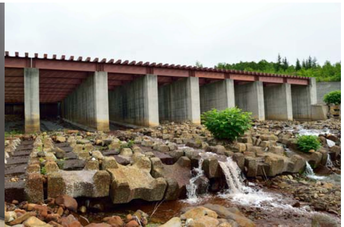
4号底面スクリーンダム
